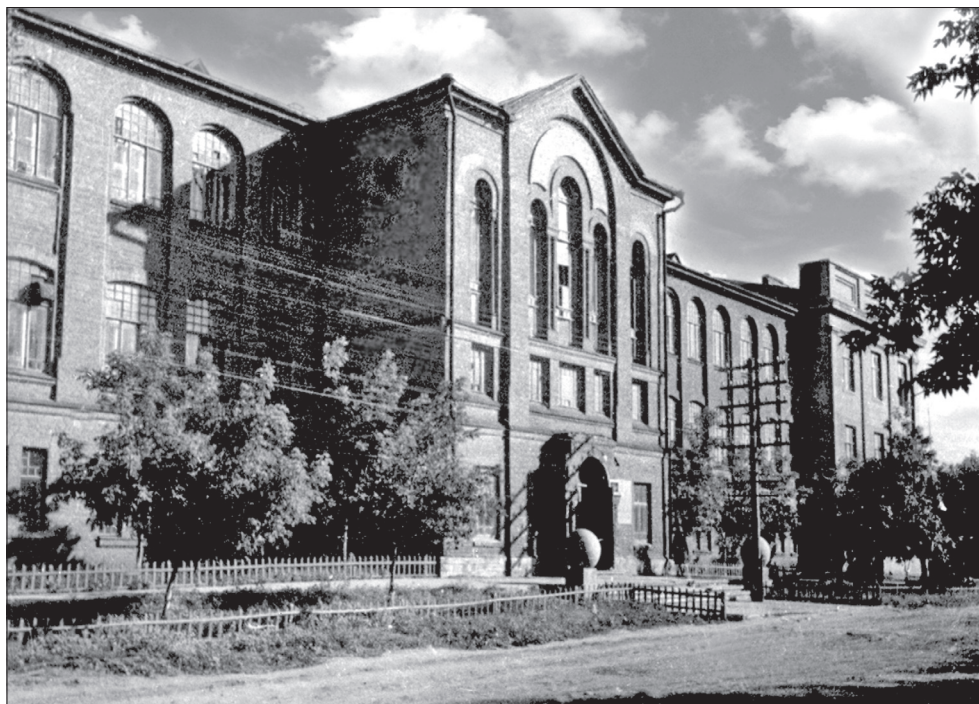
Корпус Куйбышевского авиационного института, 1942 г.
